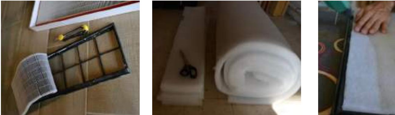
Figure 31 : Photos de la réalisation de filtres « maison » à partir d'un rouleau de médium filtrant (de type G4) : dépose du médium encrassé pour récupérer le cadre du filtre, découpe du médium filtrant neuf.
