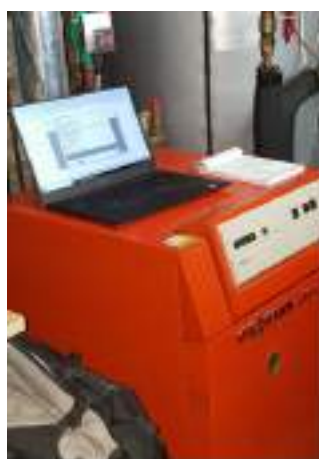
Figure 145 : photo des chaudières gaz conservées et présentant de faibles rendements. Celle de gauche est de 1998, l'année des deux autres n'est pas connue.
