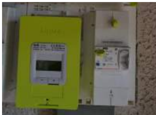
Figure 185 : Illustration – Exemple de compteur Linky.
