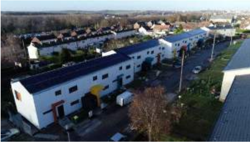
Installation photovoltaïque du projet EnergieSprong (12 maisons en bande). Source : http://www.energiesprong.fr/
