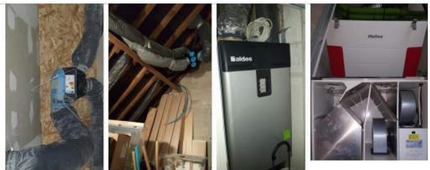
Figure 101 : Illustration de caissons d'extraction simple flux (gauche) et de centrales double flux (droite)
